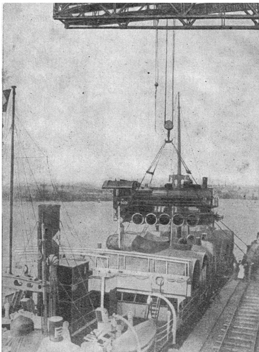
Рис. 188. Погрузка паровоза на пароход при помощи системы блоков.
